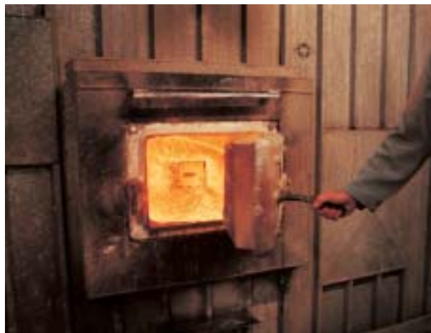
Planta de cogeneración en la fábrica de café de Mainz (Alemania), donde los restos de café molido se utilizan como combustible
